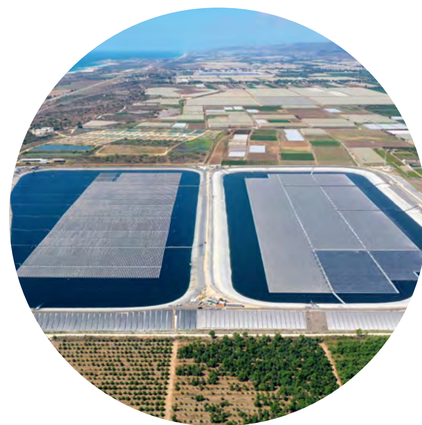
חוף הכרמל 31.4 MW
